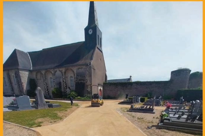
Pose de bordures et réfection du cheminement au cimetière à St-Michel-et-Chanveaux
