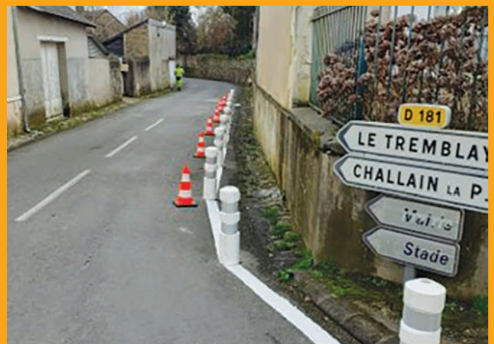
Pose de balises route du Tremblay à Noëllet
