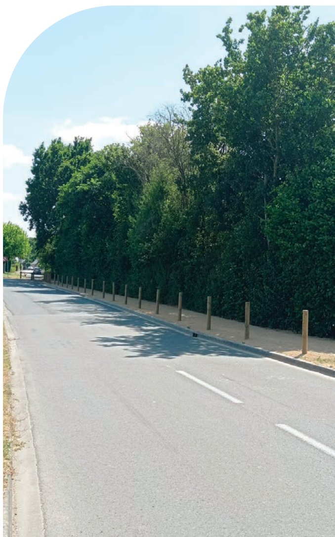
Aménagement du chemin vers le cimetière à Combrée, sécurisant les piétons et mettant davantage en valeur la haie de chênes.
