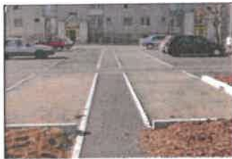
Exemple de parking réservoir à Albi
