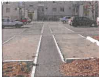
Exemple de parking réservoir à Albi
