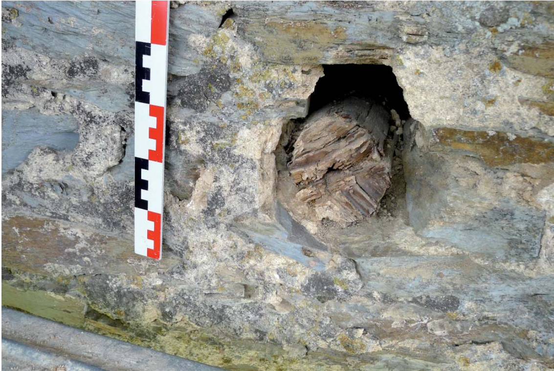
Fig. 43 : Vue de détail du boulin 1009-1 avant prélèvement.
