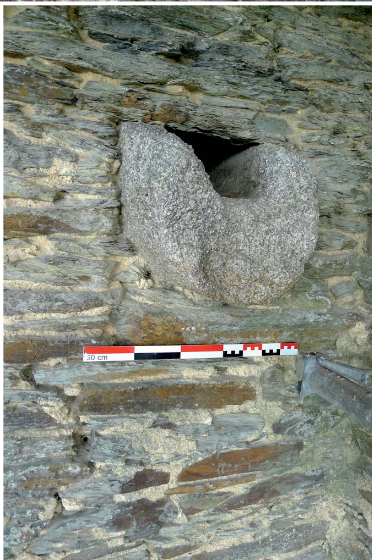
Fig. 32 : Détail de l'extrémité extérieure du canal d'évacuation sud des eaux de pluie (UE 1002).
