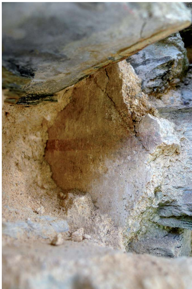
Fig. 21 : Détail de l'enduit couvrant l'embrasure d'une des fenêtre du logis 1001, avec des traces d'un décor de faux appareil peint.
