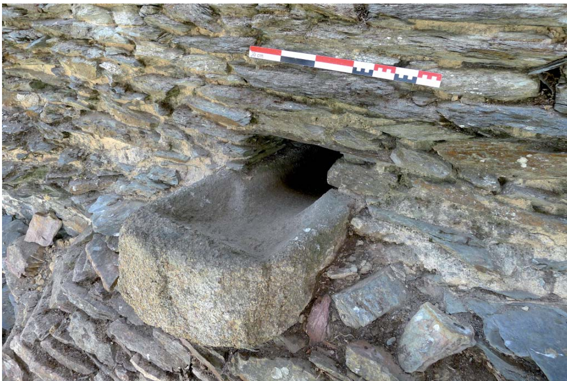
Fig. 31 : Détail du petit bassin sud collectant les eaux des chéneaux et les dirigeant vers le canal d'évacuation intramural (UE 1002).
