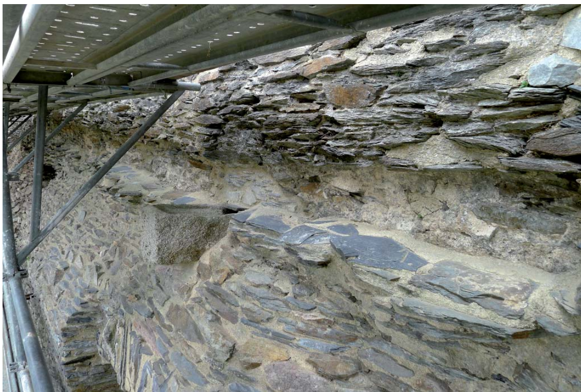
Fig. 30 : Vue des empreintes laissées dans le mortier par les pierres des chéneaux convergeant vers le canal d'évacuation nord (UE 1002).
