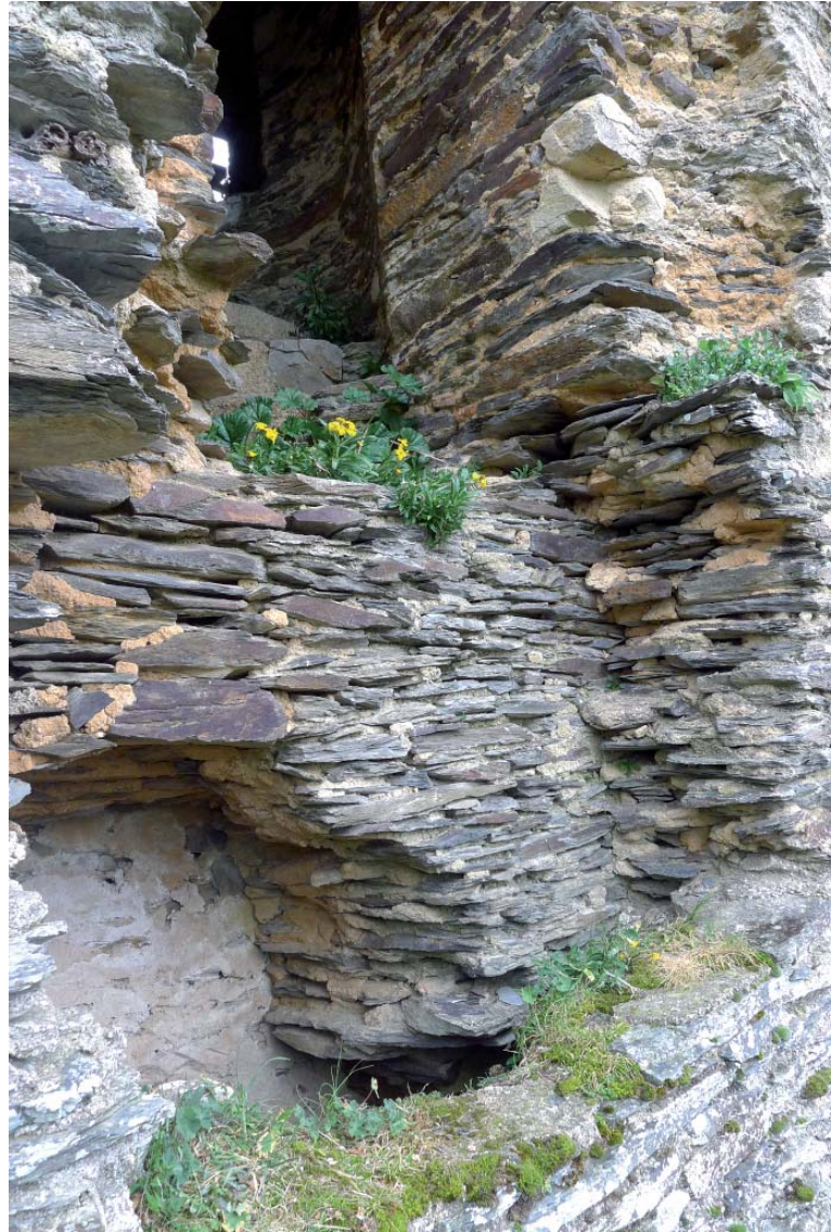
Fig. 16 : Vue de la portion de mur 1000 mise au jour après un creusement réalisé dans le parement intérieur de la courtine 1002, sous la porte menant vers l'escalier en vis. Au fond du trou s'observe le blocage du contre-mur 1001 dont le mortier est venu se plaquer contre l'élévation occidentale du mur 1000.
