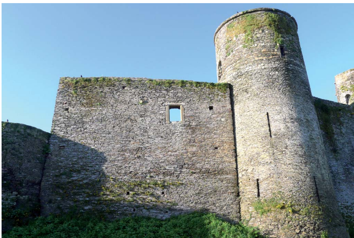
Fig. 47 : Vue de l'élévation de la courtine nord, entre la tour du Moulin et la tour Saint-Antoine, qui a été renforcée par la construction d'un contre-mur dont les caractéristiques architecturales sont très proches de celles du contre-mur 1002 étudié sur la courtine ouest.
