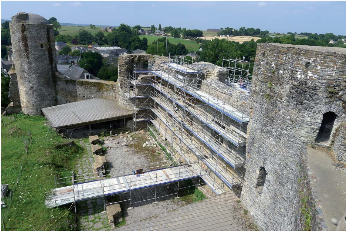
Fig. 5 : Vue générale du chantier depuis la tour Saint Antoine.
