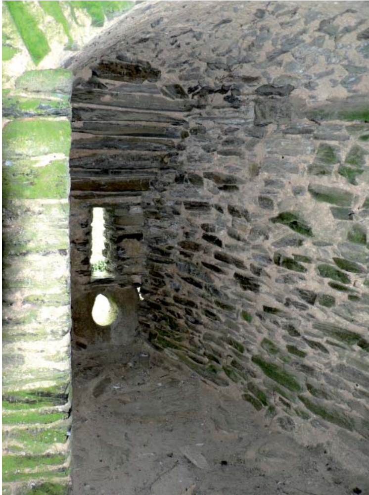
Fig. 41 : Détail d'une des canonnières du niveau 2 (rez-de-chaussée) de la tour Heptagonale.
