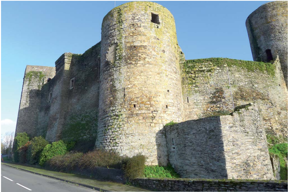
Fig. 36 : Vue de la Grosse Tour depuis le sud-ouest.
