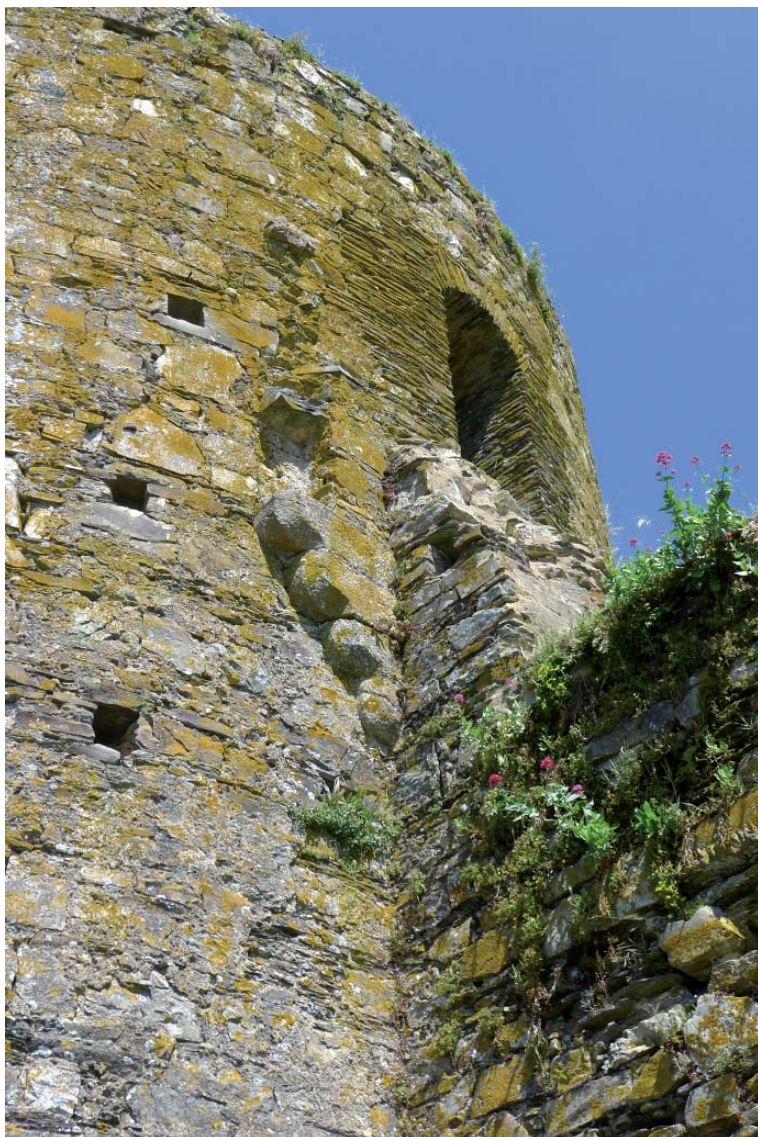
Fig. 39 : Vue de la console accolée à la Grosse Tour, constituée d'éléments superposés en quart de rond chanfreinés (UE 1004).
