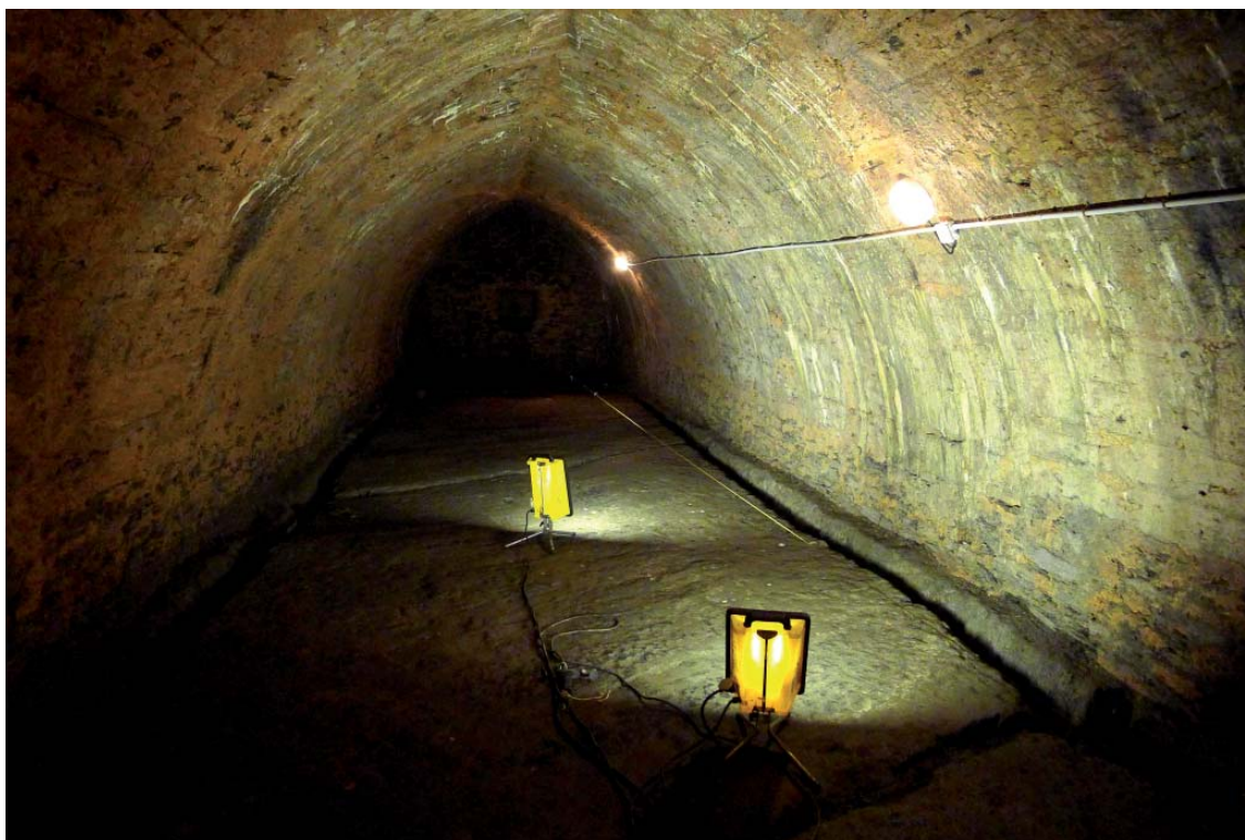
Fig. 22 : Vue de la cave 1044 depuis l'extrémité sud.
